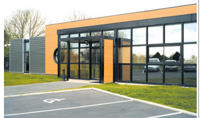
Synchronic à Franqueville Saint Pierre (76) - Charpente - Couverture - Bardage - Serrurerie.
