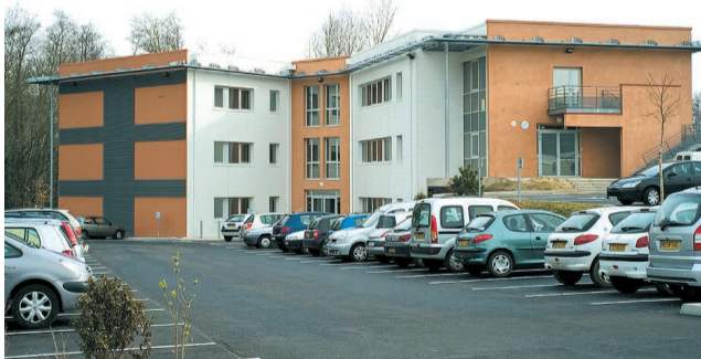
Immeubles de bureaux à Agnetz (60) - Launet est intervenu en entreprise générale.
