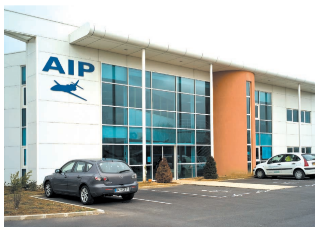
AIP (aménagement aéronautique) à Roissy (95) - Charpente - Couverture - Bardage sont de Launet.
