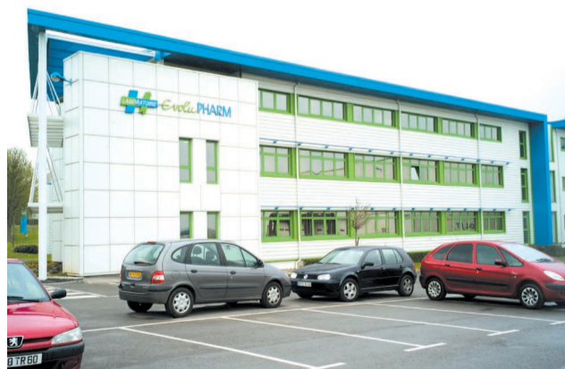
Evolupharm à Auneuil (60) - Serrurerie - Charpente - Bardage réalisés par Launet.
